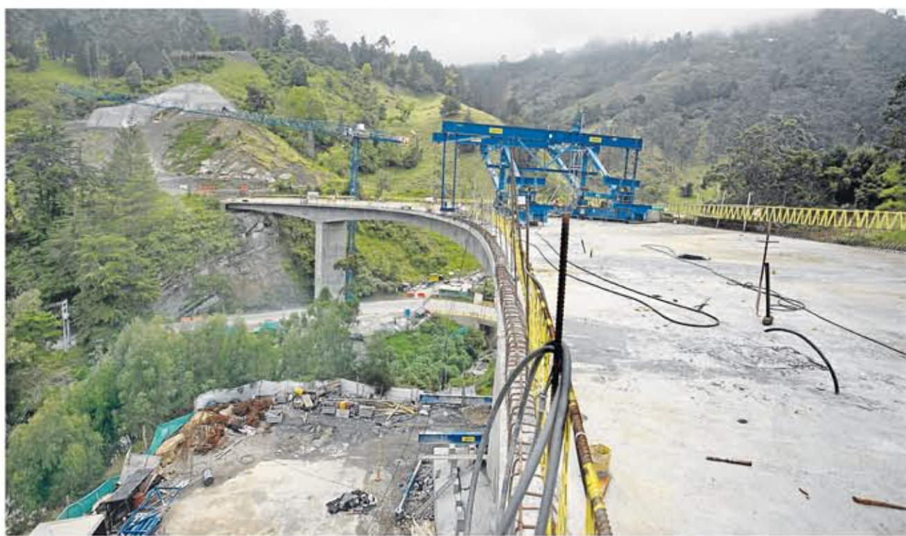
Así se observa el desarrollo de las obras de la doble calzada Pamplona-Cúcuta. / Foto Cortesía
